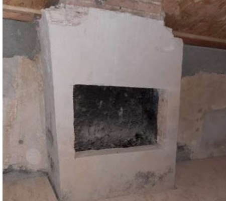
Création d'un accès par le conduit de cheminée
