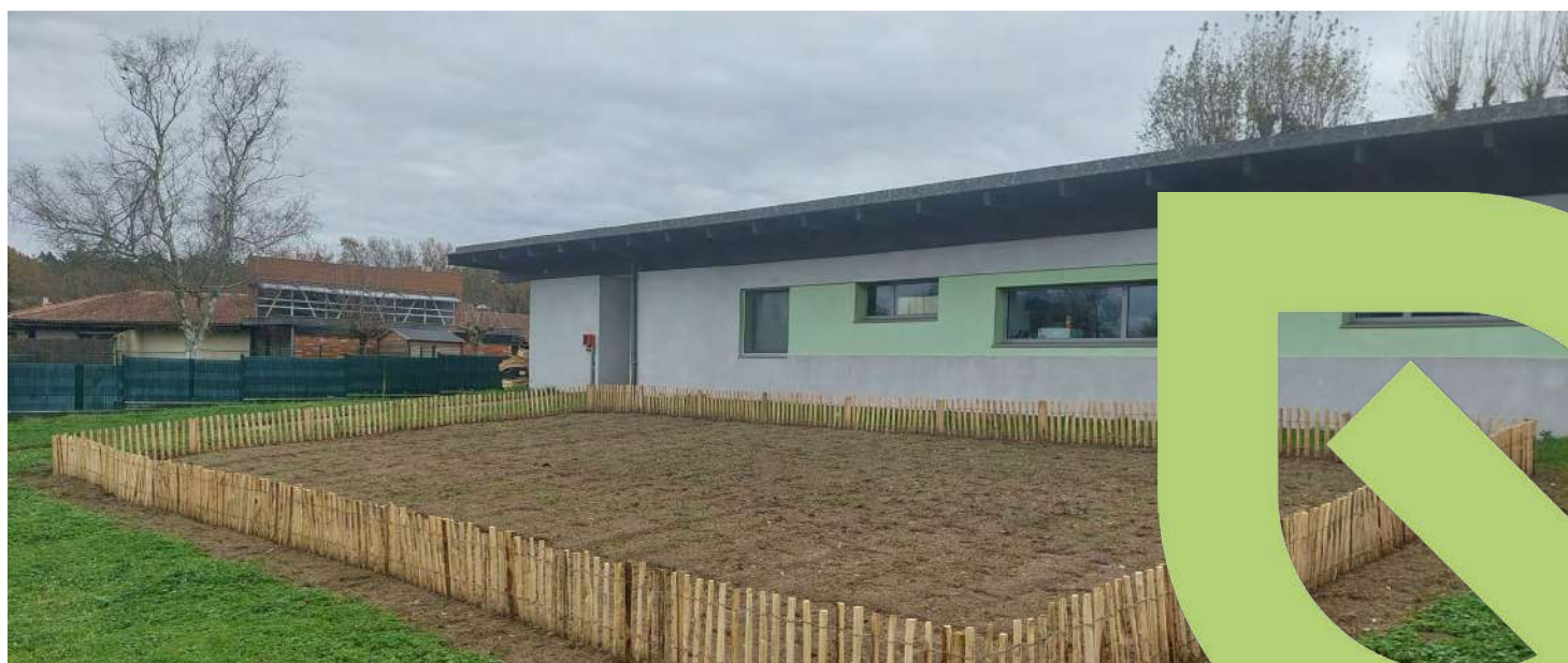
Crèche de Castelnau-de-Médoc
