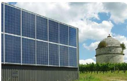
Chai viticole contemporain construit en inox avec façade recouverte de panneaux photovoltaïques, château de Camarsac, Gironde © CAUE 33
