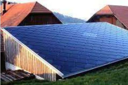
Tuiles solaires formant la toiture d'une construction annexe (garage)/ Alpes
