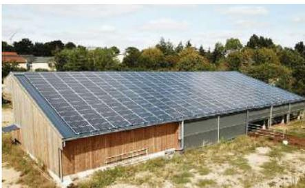
Nouvelle construction, les panneaux forment la toiture / Pannecé © Gaec de la Butte
