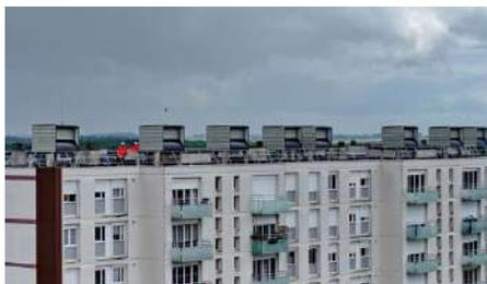
Éoliennes de toitures WindBox, Rouen,
