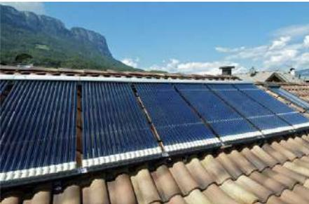
Panneaux solaires thermiques avec réservoir d'eau chaude intégré à l'intérieur du bâti. A privilégier sur les annexes © Mon Kit Solaire
